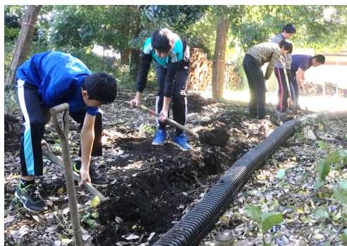
図1 パイプの設置
