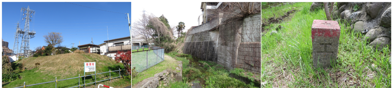
a) 落合川付近に残る土堤区間 上部空間は鉄塔と高圧線に利用
