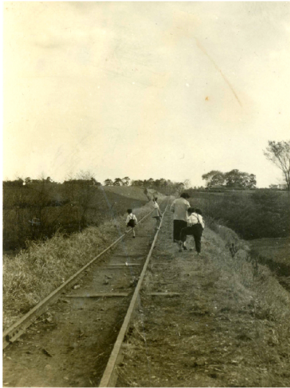
a) 立野川橋梁（土堤）付近（中島航空金属方向）
