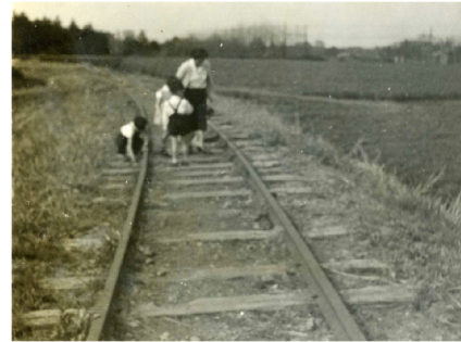
b) 立野川～落合川間，奥は西武線（東久留米駅方向）
